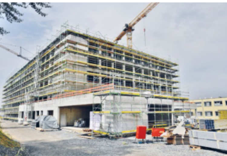
Blick auf den Rohbau des siebengeschossigen Notfall- und Intensivzentrums
