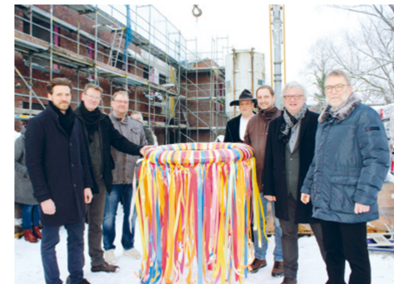
Die beiden ersten Gebäude des großen Bauvorhabens am Alexianer Martinistift stehen
